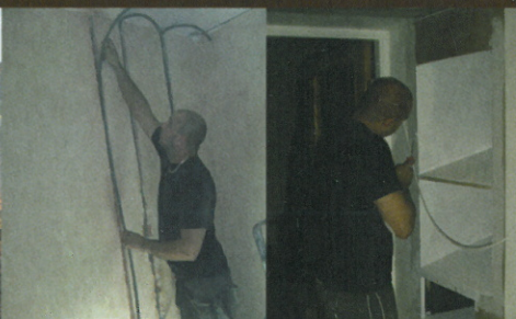
Ett grundligt arbete med infällda kabelrör – innan tapetseringen – är nödvändigt för att få osynliga kablar för elektronik och högtalare.
