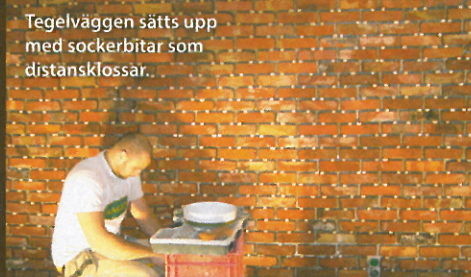
Tegelstenarna från Klippans läderfabrik sågas till 3 cm.
